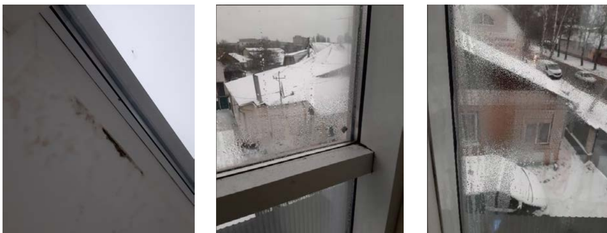
Рис.3.4. Конденсат та пліснява у залах спортивного клубу
